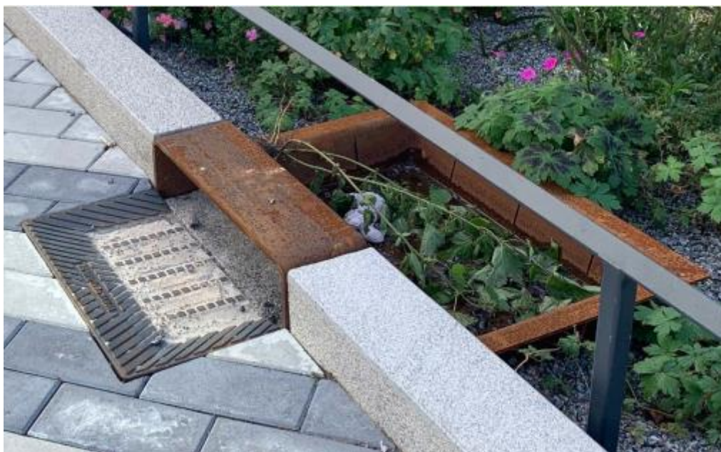
Obrázek 2 Dešťová vpusť se sedimentační vanou, usměrňující vtok vody do dešťové zahrádky
